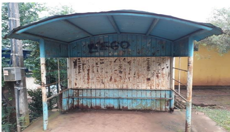
ABRIGO 13: BR 282, entrada CTG.
