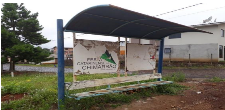
ABRIGO 6: Avenida XV de Novembro, em frente ao Hospital.
