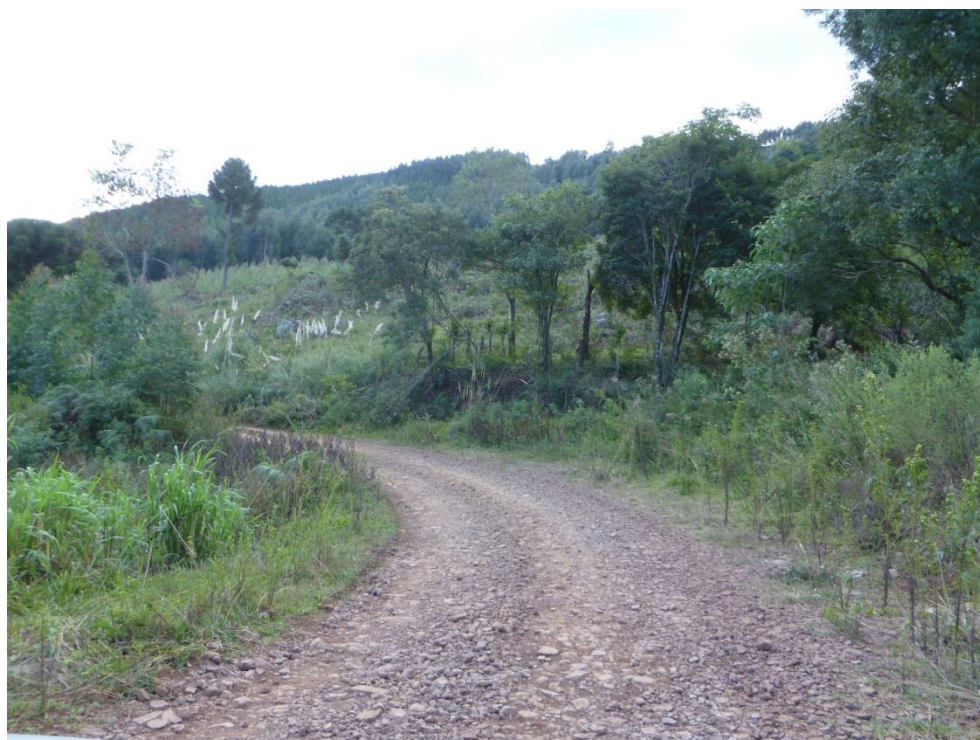
Estacas 4+240 a 4+290m – Alinhamento 01 Aumento do raio da curva - LE
