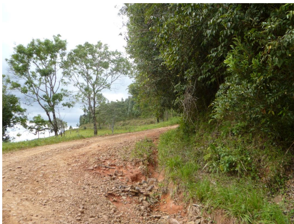
Estacas 4+207 a 4+249m – Alinhamento 03 Aumento do raio da curva - LD
