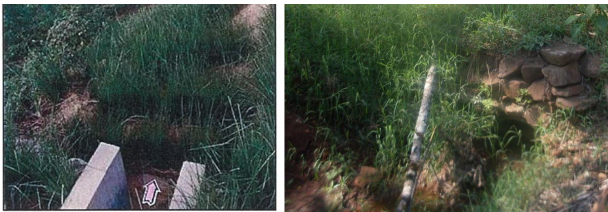
Figura 10 – Saída de bueiro protegida com vegetação
