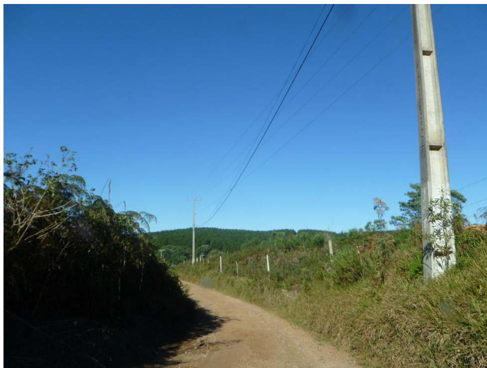
Estaca 1+247 a 1+458m – Alinhamento 02 Alargamento de pista (LE)
