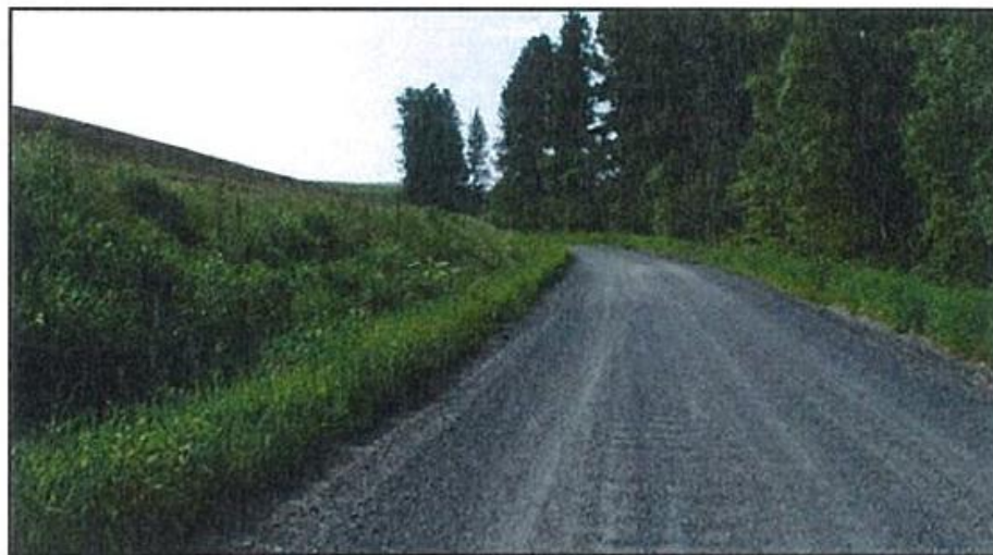
Figura 6 – Exemplo de talude protegido
