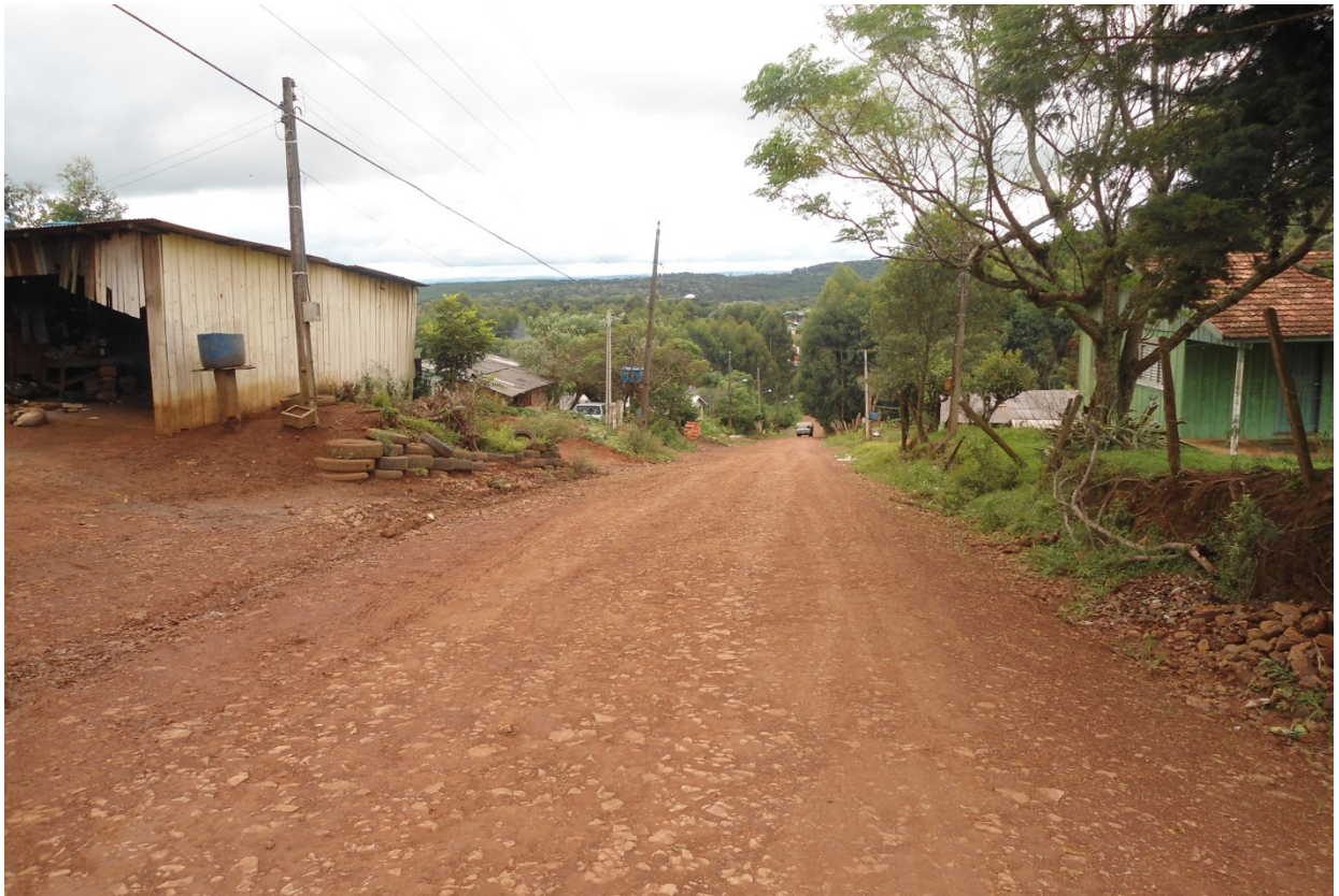
Foto 05 – Final do trecho a ser pavimentado
