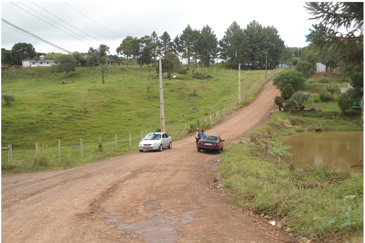
Foto 02 – Trecho a ser pavimentado
