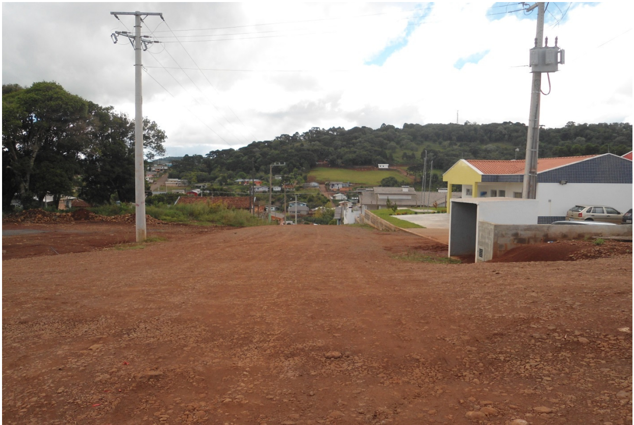
Foto 01 – Início do trecho a ser pavimentado
