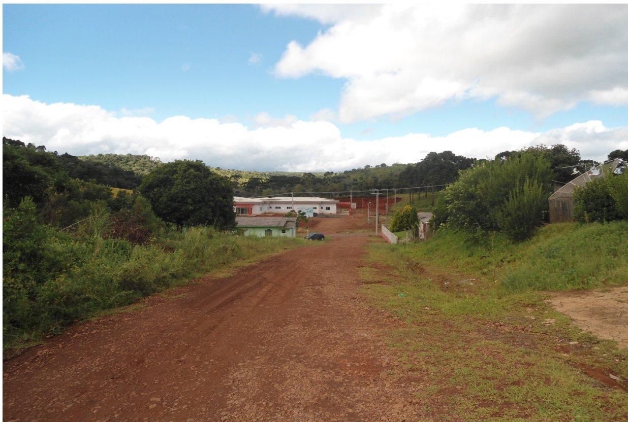
Foto 04 – Trecho a ser pavimentado
