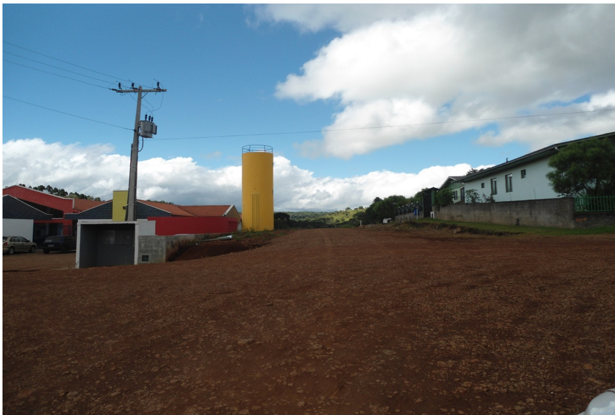
Foto 02 – Trecho a ser pavimentado
