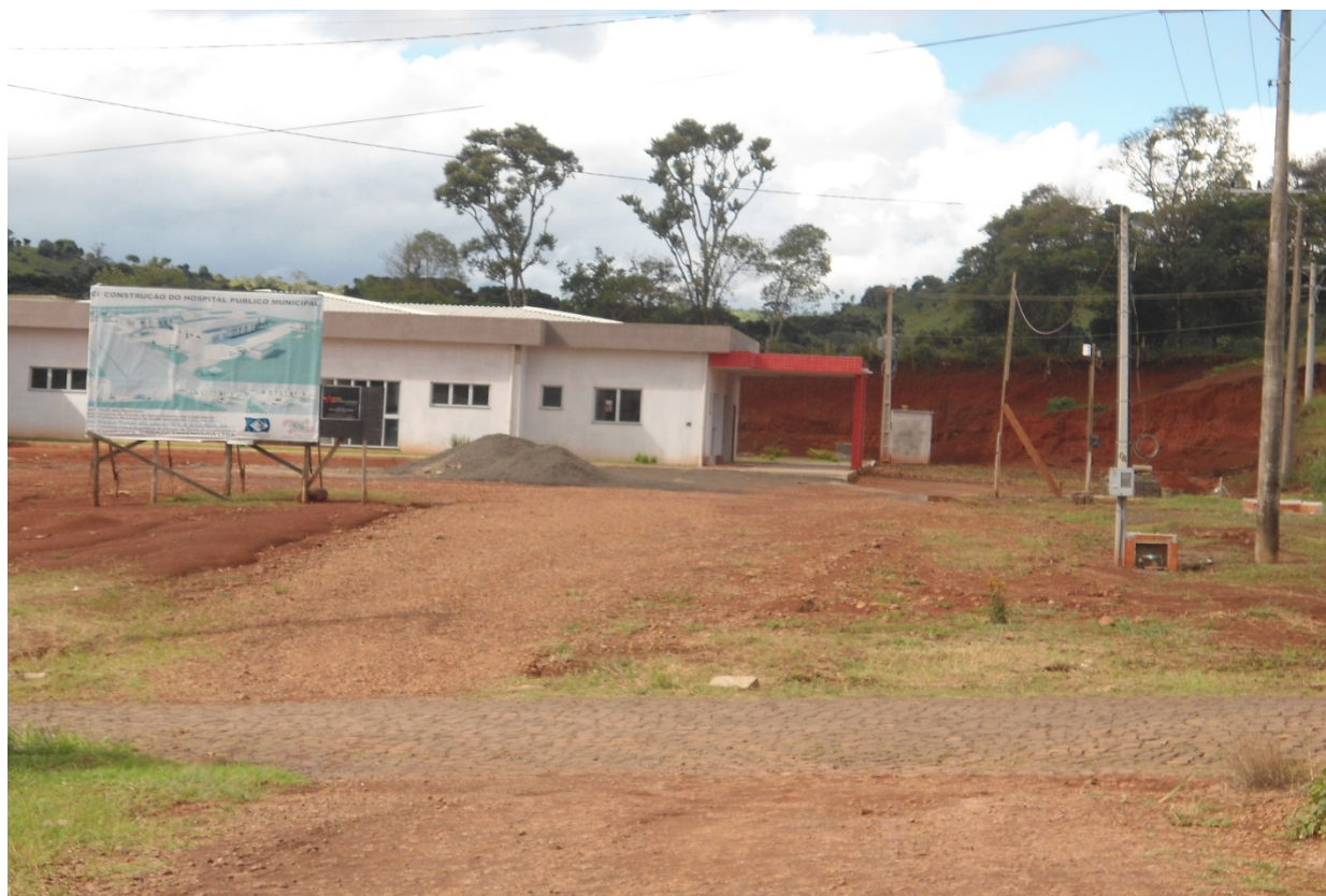
Foto 05 – Final do trecho a ser pavimentado
