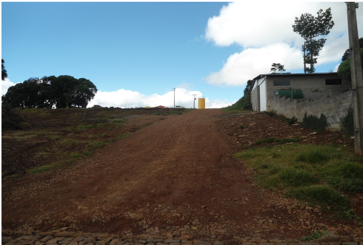
Foto 01 – Início do trecho a ser pavimentado
