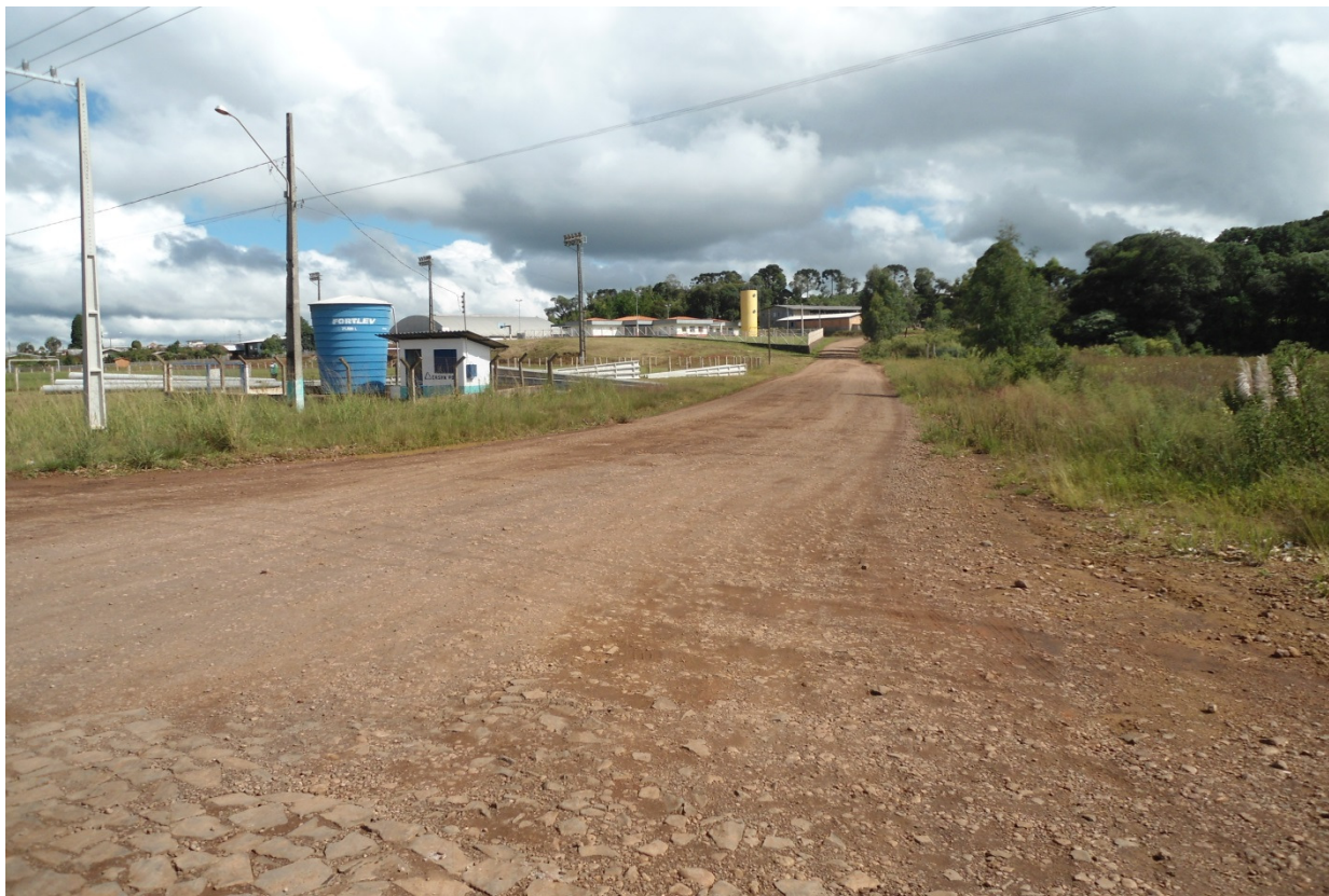
Foto 01 – Início do trecho a ser pavimentado
