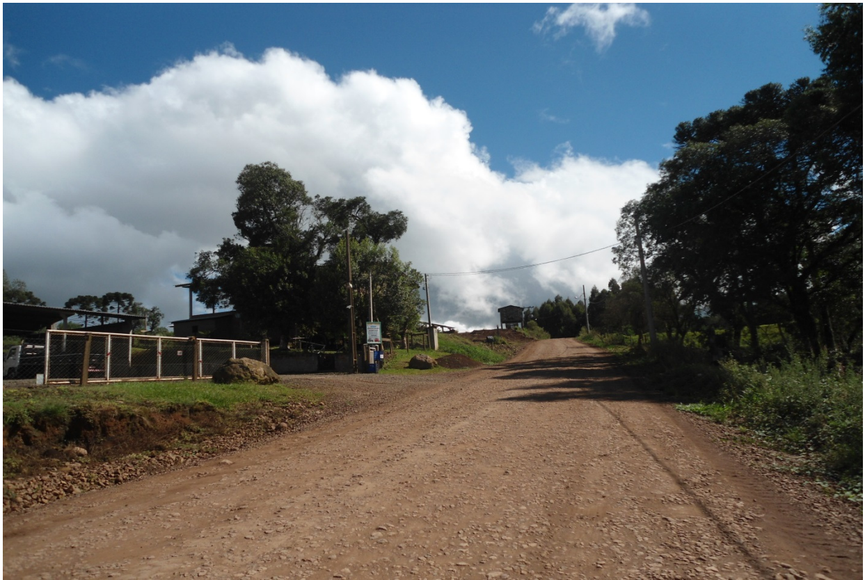
Foto 03 – Trecho a ser pavimentado
