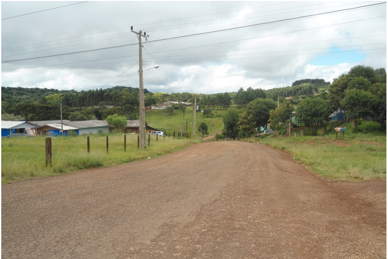
Foto 01 – Início do trecho a ser pavimentado
