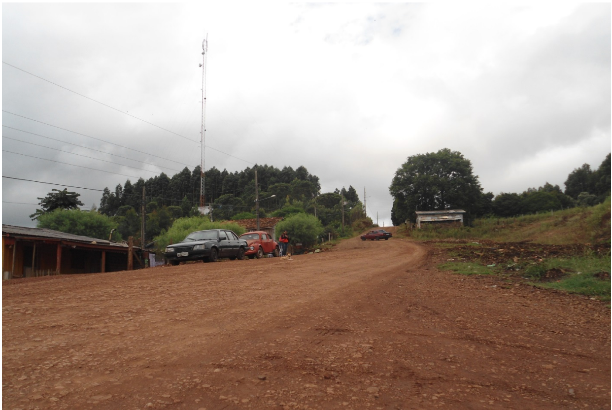
Foto 04 – Trecho a ser pavimentado
