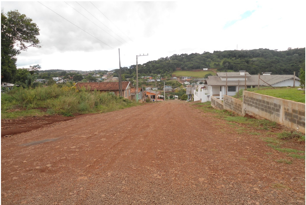
Foto 02 – Final do trecho a ser pavimentado
