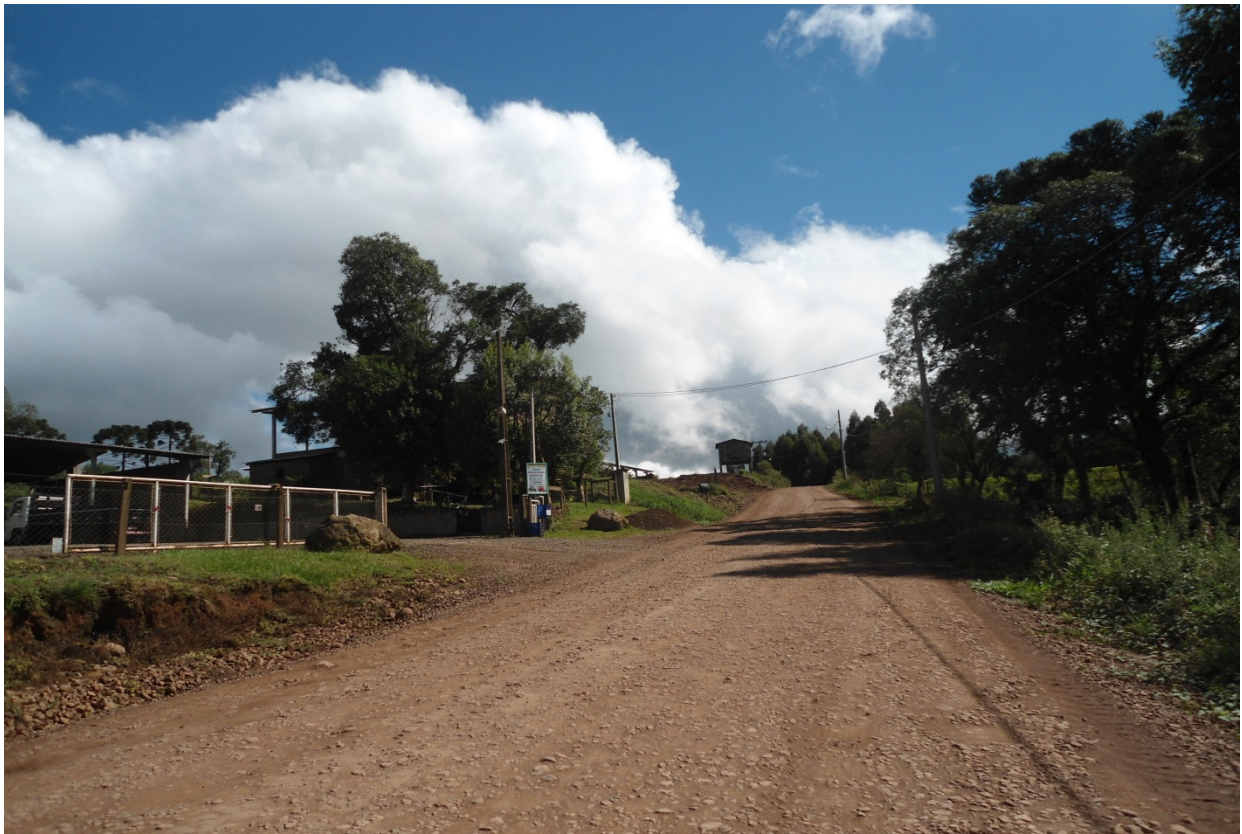
Foto 03 – Trecho a ser pavimentado
