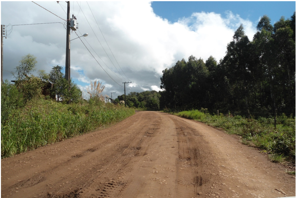
Foto 04 – Trecho a ser pavimentado
