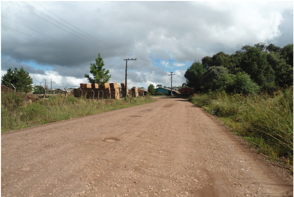
Foto 05 – Final do trecho a ser pavimentado
