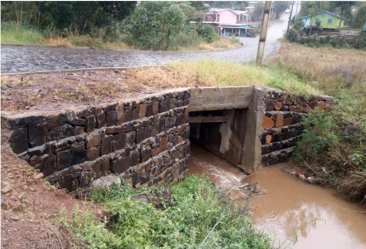
Foto 01: Ampliação da galeria do Lajeado Pouso do Maia – Muro de Contenção
